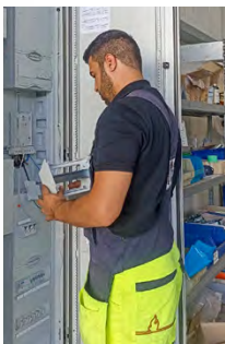
Monteur Mohamad Kmayha kümmert sich um den Zähleraustausch.
