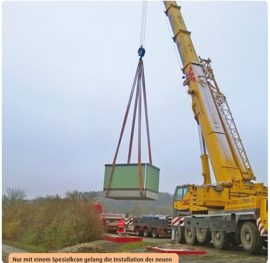
Nur mit einem Spezialkran gelang die Installation der neuen Umspannstation.
